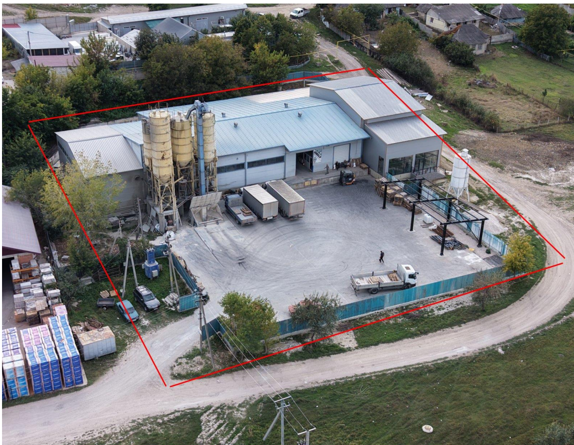
Foto 1. Com. Grățiești, str. Miron Costin 29 (nr. cad. 0155213.126) – platformă de producție exploatată de SRL „GENERAL BUILDING” (silozuri, hală, depozit), limita marcată cu roșu.
